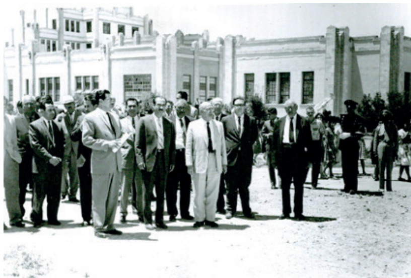
Autoridades universitarias visitan la construcción de la Facultad de Jurisprudencia en el año de 1969. Caja 16, Expediente 33, Folio 5774.
