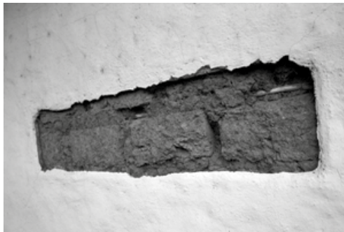
Figura 20. Recubrimientos vivienda cafetera. Elaboración propia.
