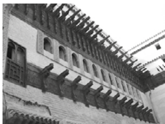
Foto 3. Edificio patrimonial de Marruecos, 2005. Fotografía de la autora.
