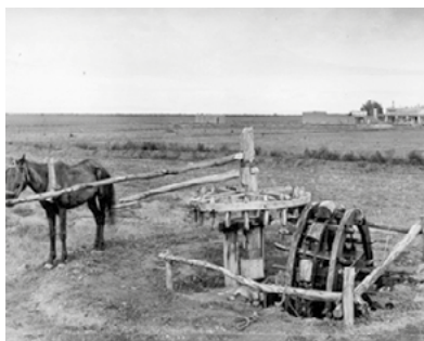
Figura 2. Noria “por lo bajo”, probablemente de Colima, primera década del siglo XX. Fotografía de Winfield Scott. Fototeca Nacional-INAH.
