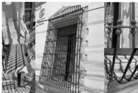
Figura 8. Detalles de ventanería Casa de la Cultura de Saltillo. Elaboración propia.
