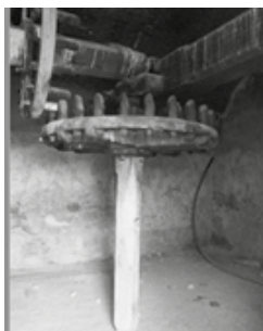
Figura 1. Mecanismo de noria “por lo alto”, en San Miguel, S.L.P. Fuente: Franco.
