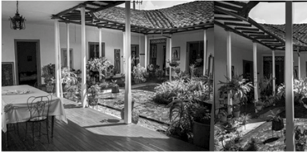
Figura 19. Columnas tradicionales Casa Toro Ceballos. Elaboración propia.
