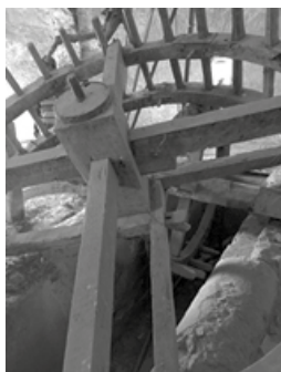
Figura 12.- Detalle del rodezno de la noria anterior, donde se observan los diferentes ensamblajes de la madera, injertos y refuerzos metálicos posteriores. Fotografía de José Ma. Reyes Gómez.
